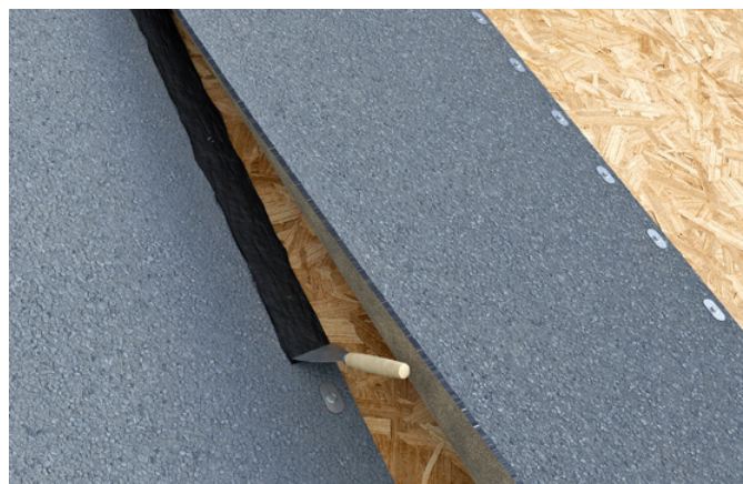
Ilustr. 347 Po przeciwnej stronie sklejaemy ze sobą zakłady klejem bitumicznym, np. swissporBITERM® STICK .
