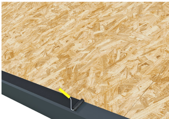
Ilustr. 359 W pierwszej kolejności gruntujemy obróbkę blacharską gruntem swissporPRIMER.
