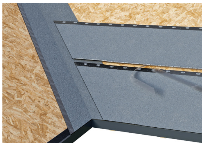
Ilustr. 357 Po stronie zakładów samoprzylepnych usuwamy folię i skleamy ze sobą zakłady podłużne dwóch pap.
