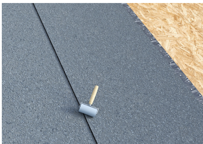
Ilustr. 344 Sklejone zakłady dociskamy wałkiem.
