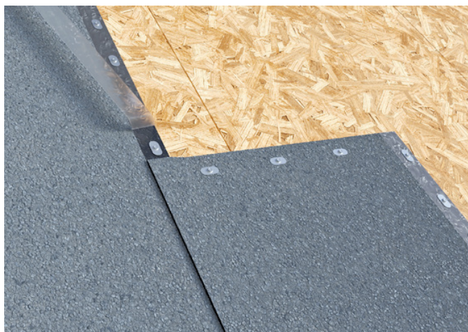
Ilustr. 336 Mocujemy membranę wkrętami nierdzewnymi z podkładkami co około 20 cm.
