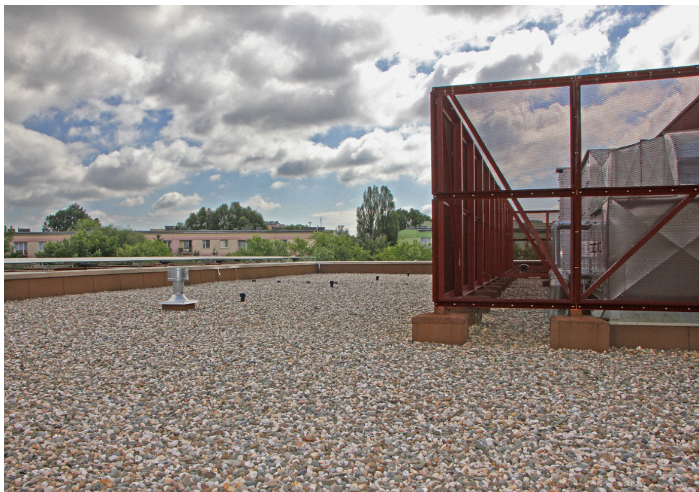
Ilustr. 286 Przykład dachu balastowego
