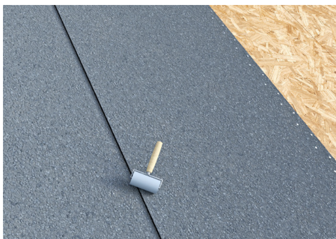
Ilustr. 353 Sklejone zakłady dociskamy wałkiem.
