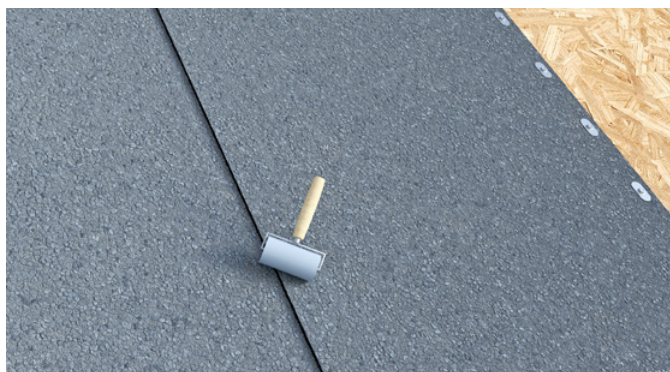
Ilustr. 346 Mocujemy wkrętami prawą stronę zakładu podłużnego drugiego arkusza papy.
