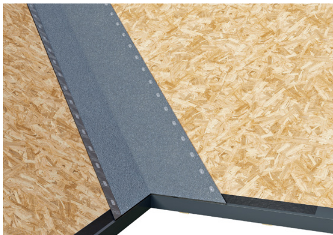
Ilustr. 354 W koszach zlewowych układamy papę z przerzuceniem na drugą część dachu.
