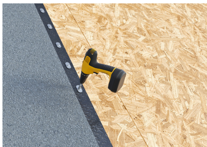
Ilustr. 331 Mocujemy zakład podłużny wkrętami nierdzewnymi z podkładkami co około 20 cm.
