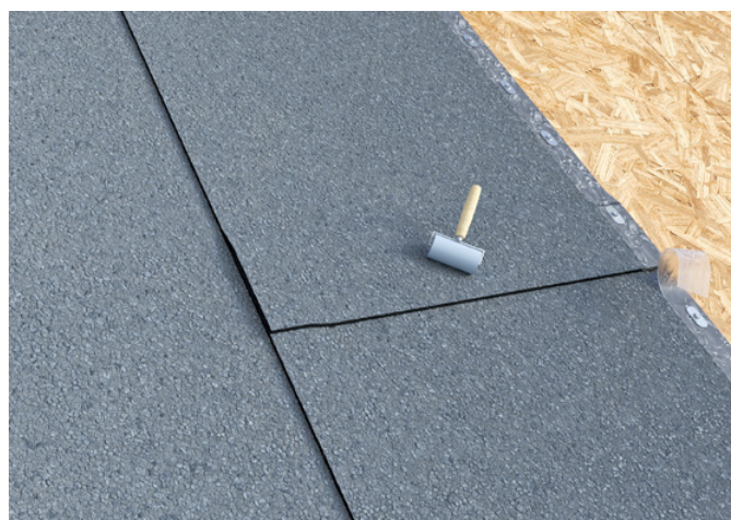
Ilustr. 339 Sklejone zakłady dociskamy wałkiem.
