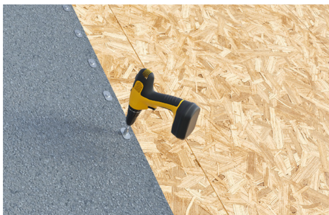
Ilustr. 344 Mocujemy zakład podłużny wkrętami nierdzewnymi z podkładkami co około 20 cm.
