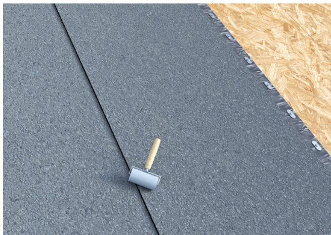
Ilustr. 335 Sklejone zakłady dociskamy wałkiem.
