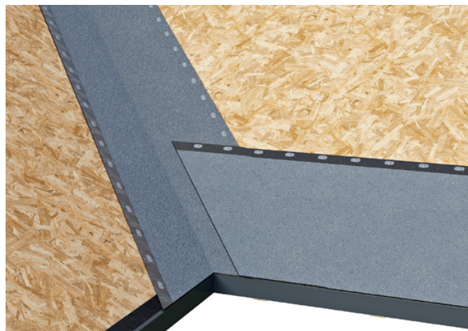
Ilustr. 355 Pierwszy pas papy mocujemy z przesunięciem 15 cm od osi kosza, w zależności od nachylenia dachu – prostopadle lub równoległe do kalenicy.
