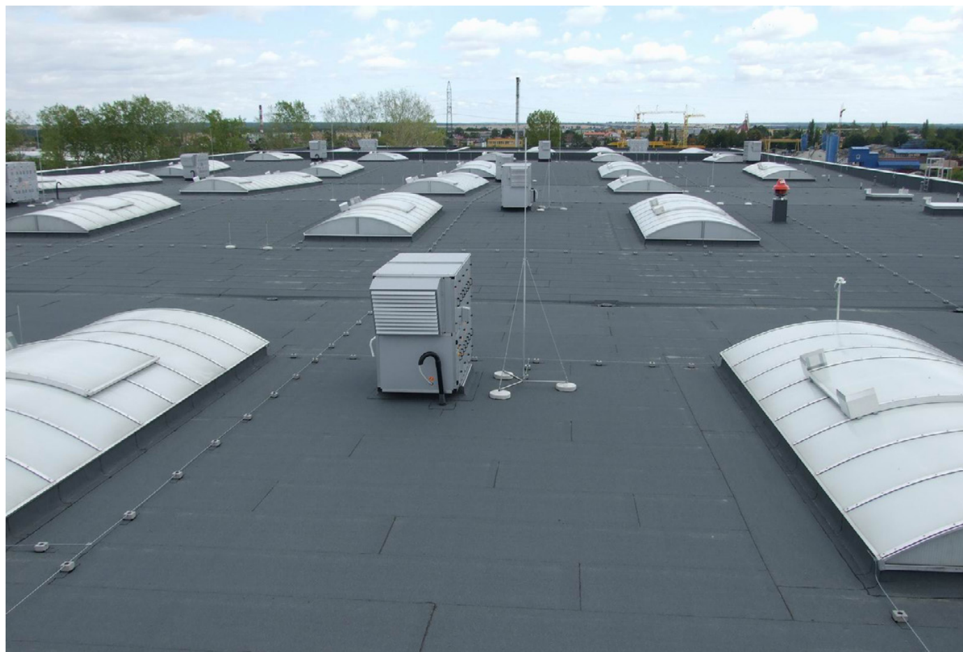
Ilustr. 1 Dach pokryty papą
